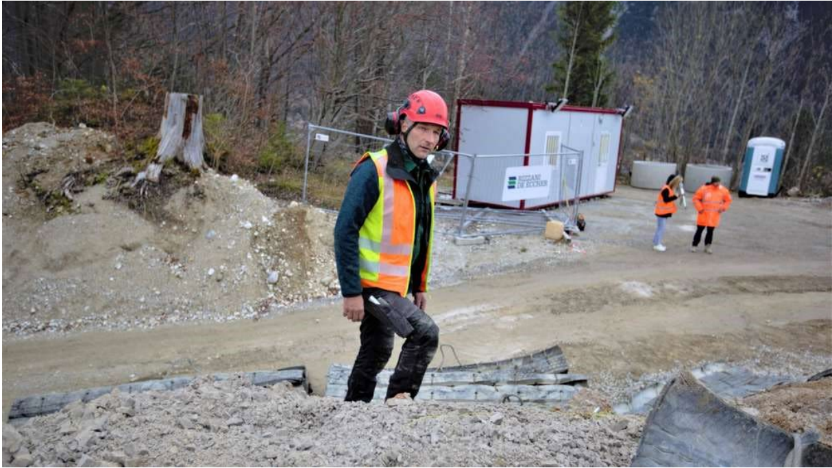
Explosionen sind sein Leben: Arno Bade begutachtet nach der Sprengung den pulverisierten Felsen am Latscheneck. © Josef Hornsteiner
